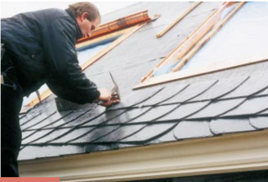
Anschließend wird der Schiefer auf die Schalung genagelt.
